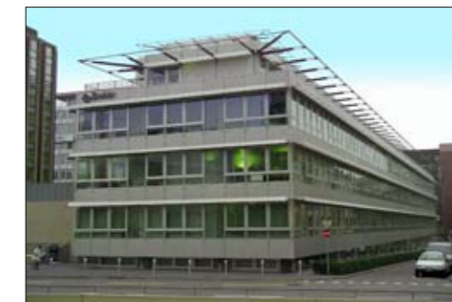
Objekt: Basler Versicherung, Basel Metallbauer: Karl Steiner Industrie AG, Zürich Eloxeur: Büro AG, Büren an der Aare Material: ALCAN J57S, häuselmann metall, Dietlikon
